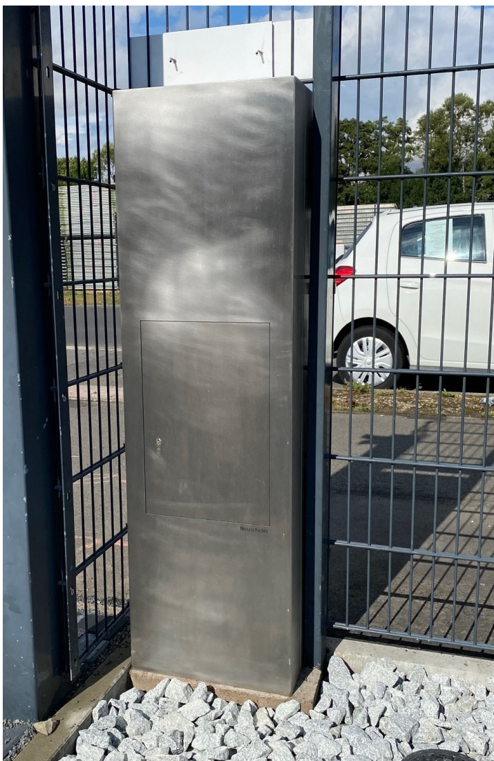
// ES5 in Ausführung V2A Edelstahl, mit Entnahmetürer auf der Rückseite
