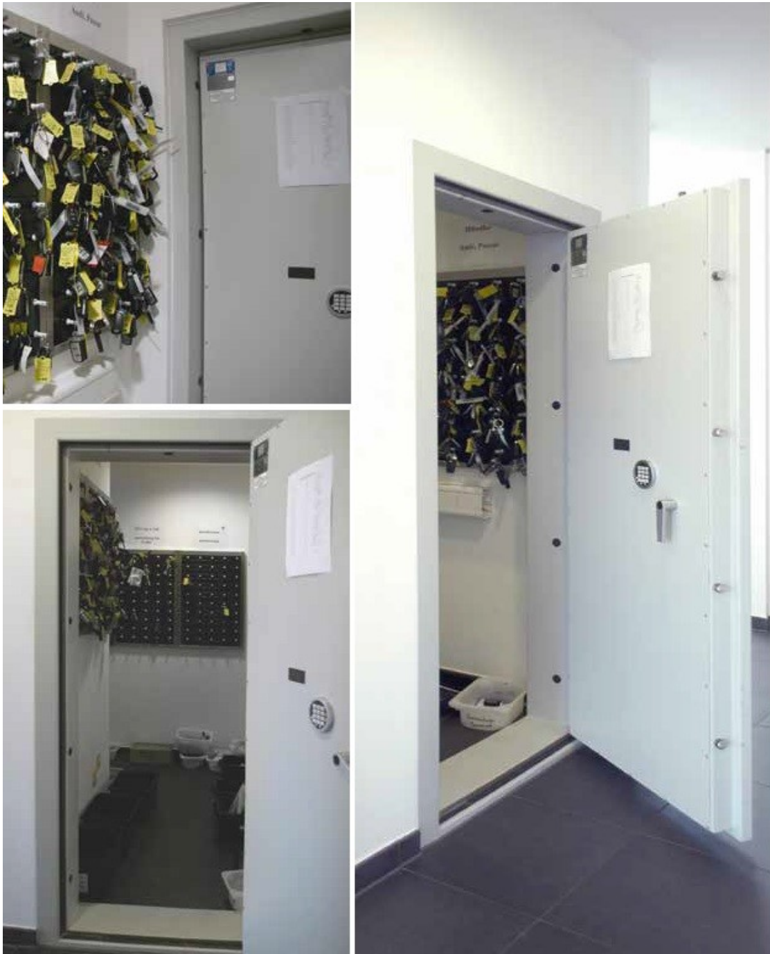
// Einbau Beispiel mit elektr. Codeschloss
